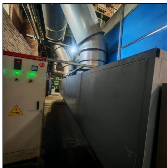
伸缩房集气口及排气管道
